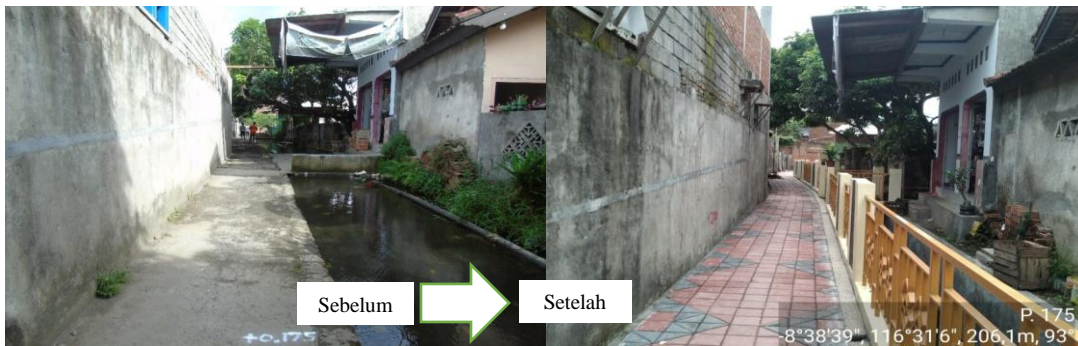
Gambar 1. Pembangunan infrastruktur saluran drainase sangkon
