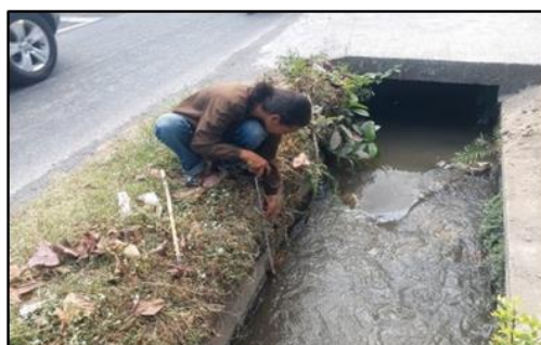
Gambar 5. Karakteristik Saluran Drainase di Jalan Gunung Salak (Sumber: Survei Penulis, 2024)
